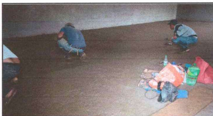
Foto 3: Avance de sustitucion de piso.
