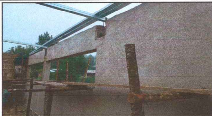
Foto1: Avance de repello de pared.
