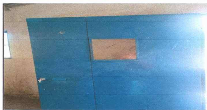
Foto 6: Colocacion de puerta metalica.
