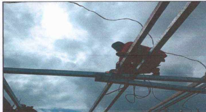
Foto 2: Avance de estructura metalica.
